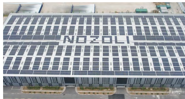
临港玛瑙园——诺倬力数控 光伏发电项目正式并网
