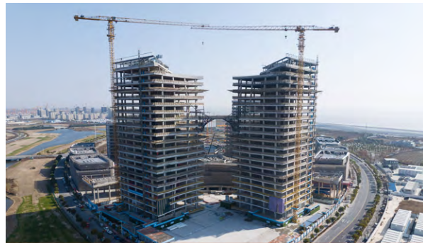
“鲲鹏之门”项目主体结构基本完成
