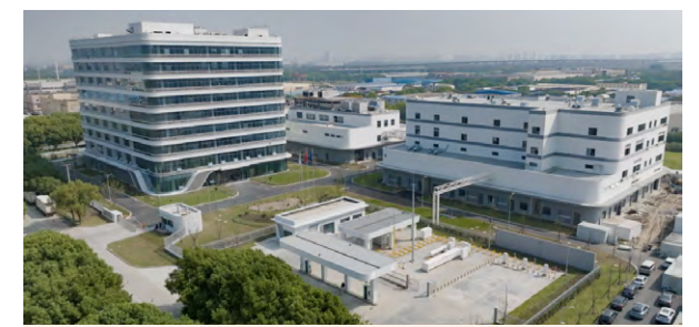
氢能与燃料电池检测基地
