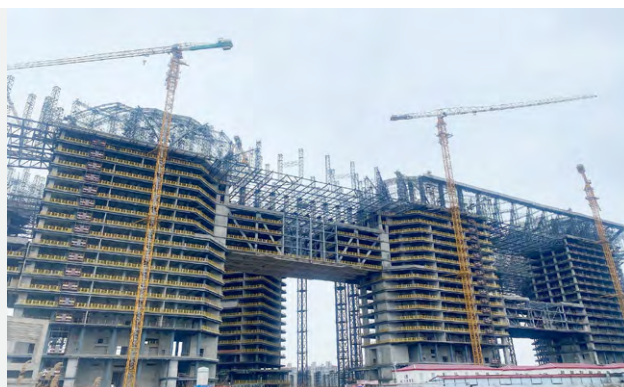
G60 科创云廊二期云顶完成施工
